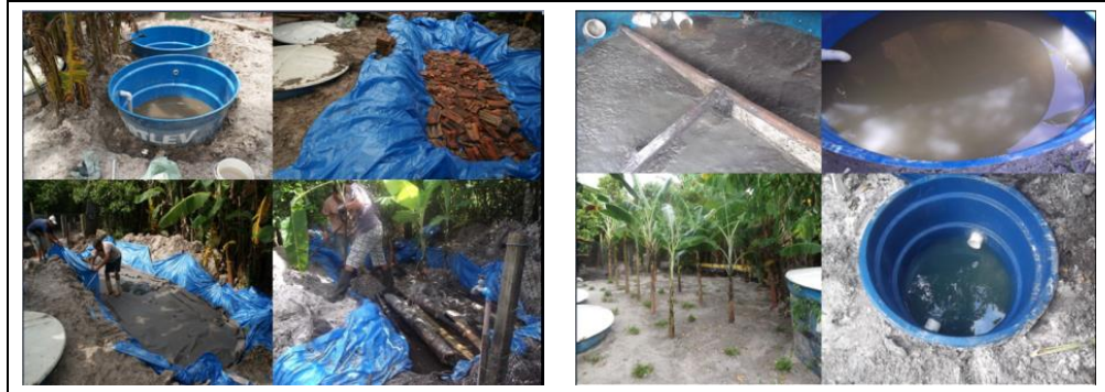
Figura 01. Etapas de construção
